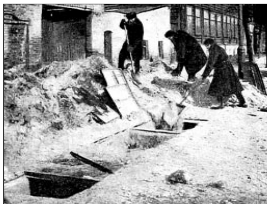
Рис. 2. Стационарная снеготаялка инженера Д.В. Домашнева при банях на ул. Библиотечная — люки для загрузки снега
