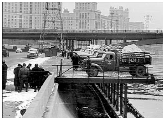
Рис. 4. Сброс снега с набережной Москва-реки со специальной эстакады
