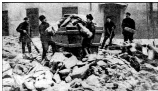
Рис. 3. Передвижная снеготаялка с дровяной топкой
