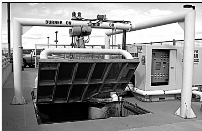
Рис. 21. Стационарная снеготаялка на газовом топливе Trecan 20-SG производительностью до 40 т/ч
